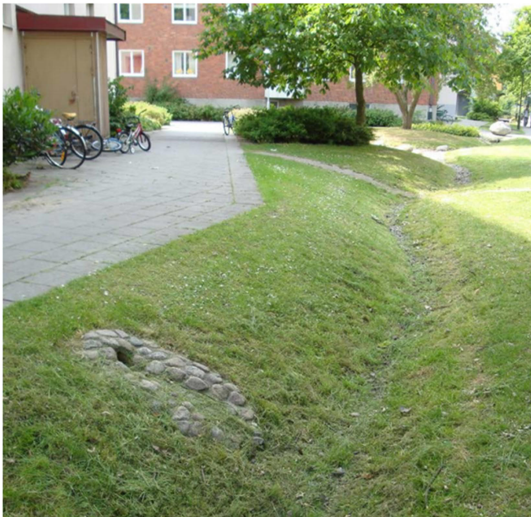
Figur 18 Exempel på hur ett svackdike kan se ut. (Sweco, 2021f)
