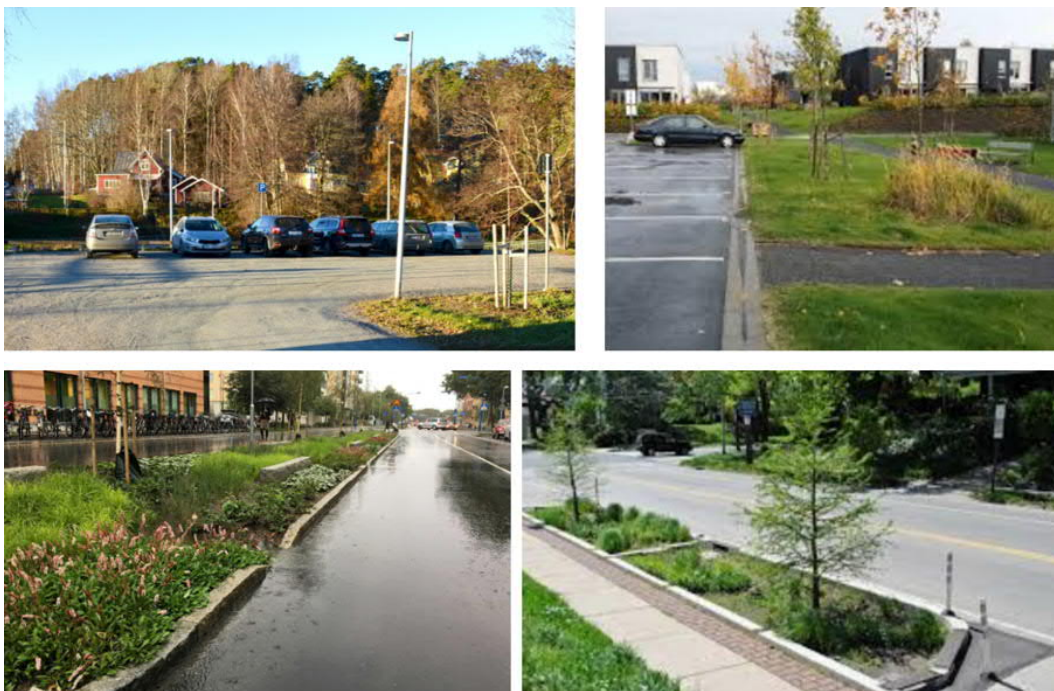
Figur 19 Exempel på biofilter i vägar och parkeringsytor (Sweco, 202f)
