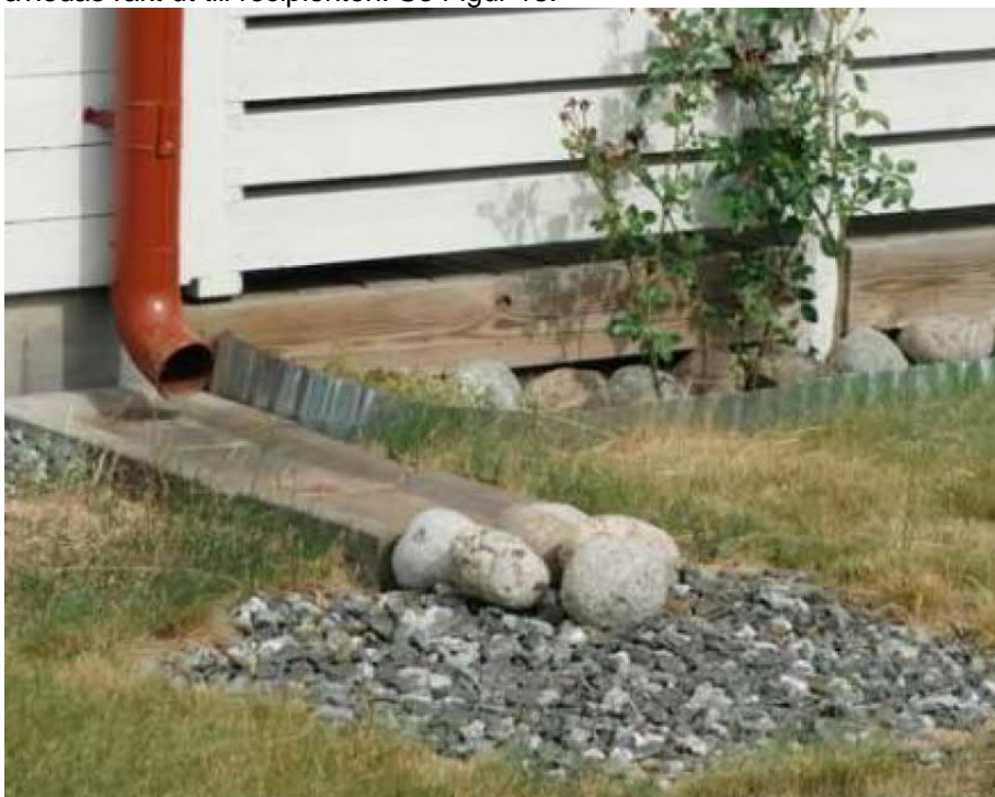
Figur 13: Stuprörutkastare med rännvidsplattor med erosionsskydd som leder ut vattnet på gräsmatta. Foto: Dagvattenhandbok Haninge kommun 2019.
