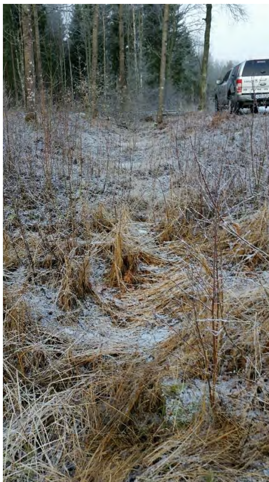
Dike sett från trumma 1 in mot flygplatsområdet
