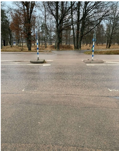
Figur 5. Passage över Stora Råppevägen (öster om Östra Råppevägen)
